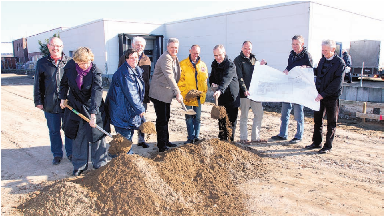
Mit dem ersten Spatenstich leiteten Mitarbeiter der Büngern-Technik die Werkstatterweiterung in Mussum ein. Foto: sb
