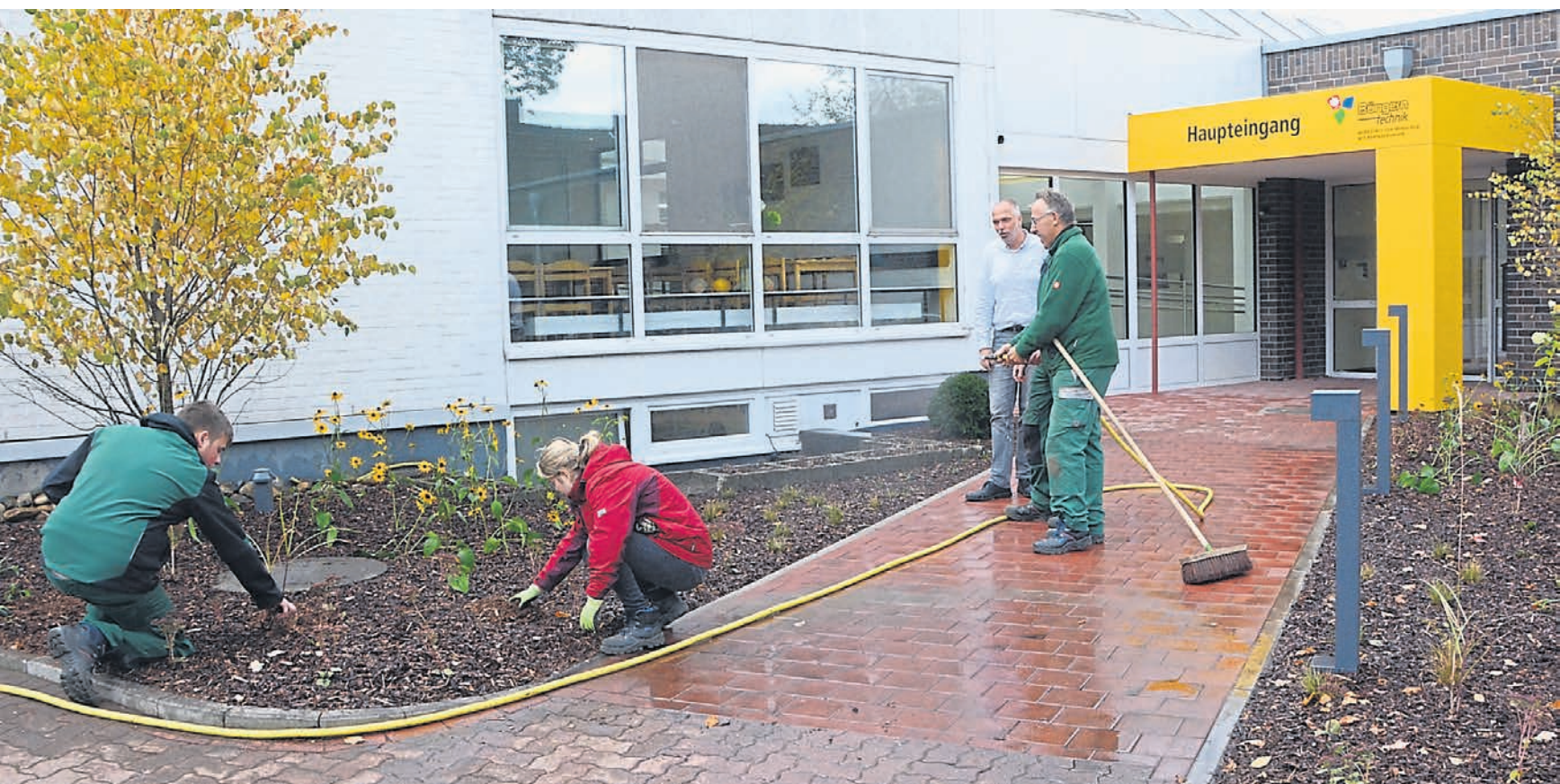
Die Gärtner sind inzwischen fertig mit den letzten Arbeiten. Damit ist der Umbau abgeschlossen.
